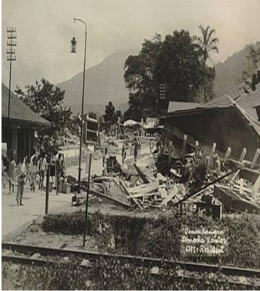
Gambar 1 Ambruknya Bangunan Kantor Asisten Residen Padang Panjang Akibat Gempa 1926
